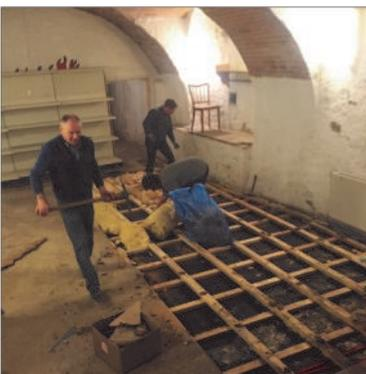
Im Kellerraum, in dem in den letzten Jahren der Flohmarkt abgehalten wurde – liebevoll „Flohkeller“ genannt, war der Boden durch einen Wasserschaden stark in Mitleidenschaft gezogen. Dank vieler helfender Hände konnte der Boden samt Unterbau entfernt werden, die Wände wurden abgekratzt, ausgemalt und rund-
